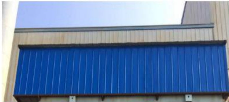
脉冲阀噪声源消声罩
